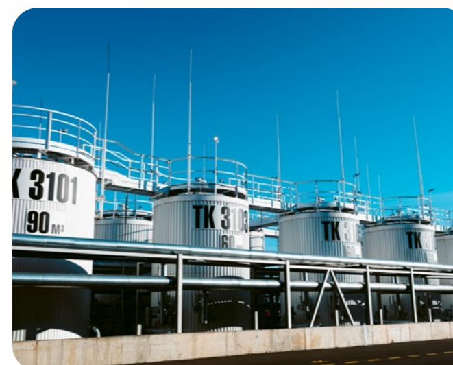
Резервуарный парк 5600 м 3
